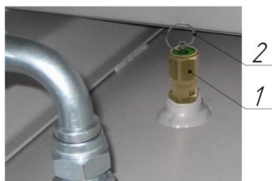
Рисунок 7 – Клапан предохранительный пружинного типа
