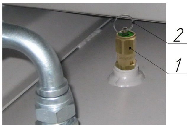
Рисунок 11 – Клапан предохранительный пружинного типа
