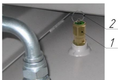
Рисунок 8 – Клапан предохранительный пружинного типа
